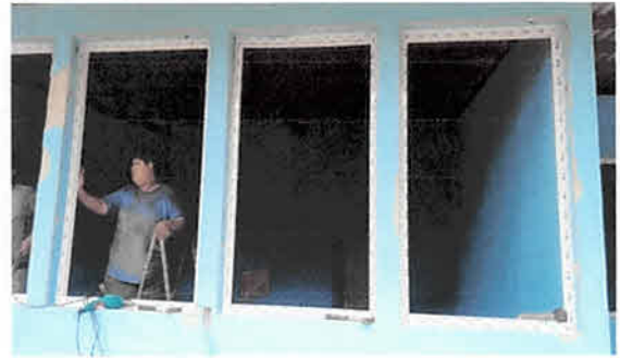
Foto 2: Sustrucción de ventanas por ventanas de PVC
